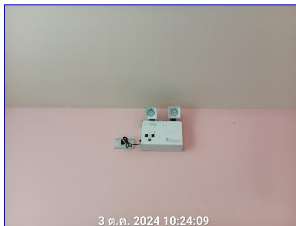
รูปที่ 2.41 ไฟส่องสว่างฉุกเฉิน
